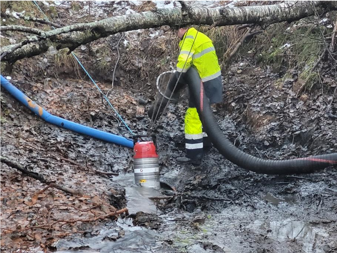
Slamsugning samt renspolning av källan. Tungt, tufft och smutsigt arbete.
